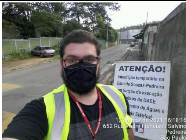
Foto 10 – Apoio no bloqueio de vias para o desmonte de rocha – Rua Padre Francisco Salvino. (12/03/2021)
