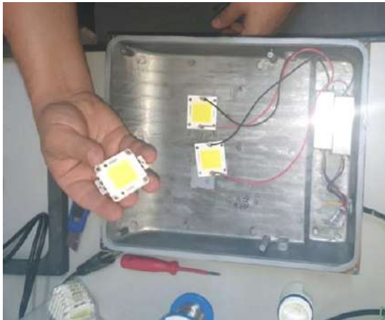
Substituição da placa de "led".
