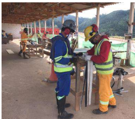
Reaproveitamento de mangueira para abafador, usado para apagar fogo.
