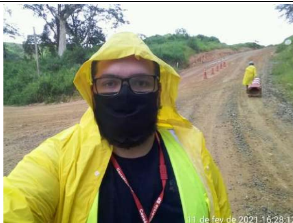
Foto 6 – Apoio no bloqueio de vias para o desmorte de rocha – ADA. (11/02/2021)
