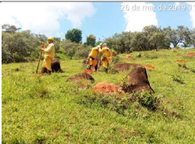
Foto 1 – Colaboradores preparam o local para o cercamento de APP do Laudo 19 (26/03/2019).
