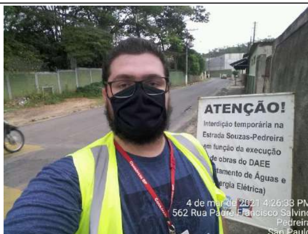
Foto 4 – Apoio no bloqueio de vias para o desmorte de rocha - Rua Padre Francisco Salvino. (04/03/2021)
